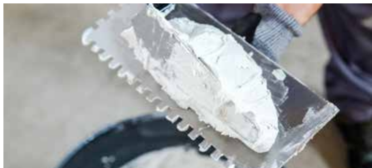
Spread the adhesive cement with a toothed trowel | Extiende el cemento de agarre con una llanta dentada | Étendre le ciment à prise rapide à l'aide d'une spatule dentée | Verstreichen Sie den Klebemörtel mit einem Zahnpachtel
