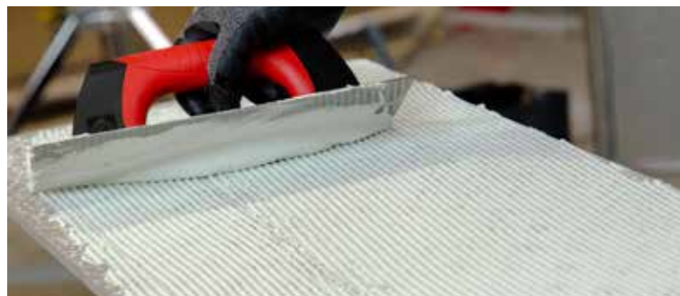
Make sure the thickness of the layer of adhesive cement is uniform | Asegúrate de que el grosor de la capa de cola sea uniforme | Veiller à ce que l'épaisseur de la couche de colle soit uniforme | Vergewissern Sie sich, dass die Kleberschicht gleichmäßig ist
