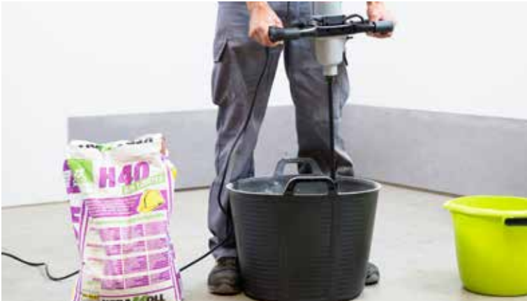
Prepare the adhesive cement | Prepara el cemento de agarre | Préparer le ciment à prise rapide Bereiten Sie den Klebemörtel vor
