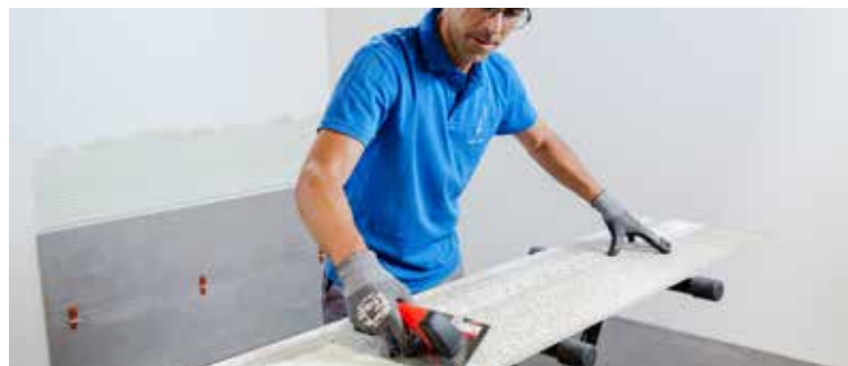
Spread the adhesive cement with a toothed trowel on the tile | Extiende el cemento de agarre con una llanta dentada sobre la pieza | Étendre le ciment à prise rapide à l'aide d'une spatule dentée sur la pièce | Verstreichen Sie den Klebemörtel mit einem Zahnpachtel auf der Fliese
