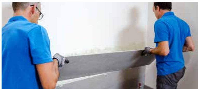
Affix the tile to the pre-prepared surface | Coloca la pieza sobre la superficie preparada | Placer la pièce sur la surface préparée | Verlegen Sie die Fliese auf der vorbereiteten Oberfläche
